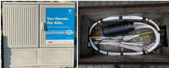
Glasfaserverteilung mittels Schrank oder Muffe
