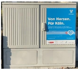
Glasfaserverteilung (Schrank oder Muffe)
