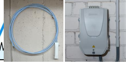
Gebäudeeinführung & LWL-Abschluss
