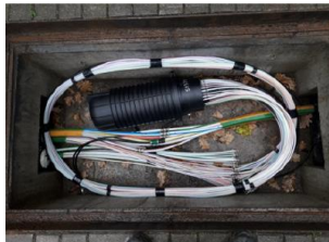
Glasfaserverteilung (Schrank oder Muffe)
