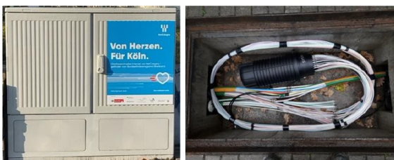
Glasfaserverteilung (Schrank oder Muffe)
