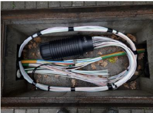
Glasfaserverteilung (Schrank oder Muffe)
