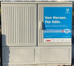
Glasfaserverteilung (Schrank oder Muffe)
