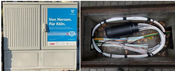
Glasfaserverteilung mittels Schrank oder Muffe
